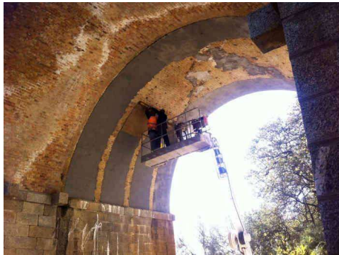
Figura 1. Illustrazioni di dettaglio delle configurazioni d'impasto nelle volte rinforzate con CRM (a) all'estrovasso e (b) all'infrodasso.
