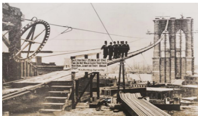
Fig. 10 - John Roebling: in alto, da sinistra, il ponte sulle cascate del Niagara e il ponte Cincinnati-Covington, a lui intitolato; in basso, da sinistra, il ponte di Brooklyn durante il montaggio dei cavi, ben visibile la “spinning wheel”, e dettagli dei cavi.
