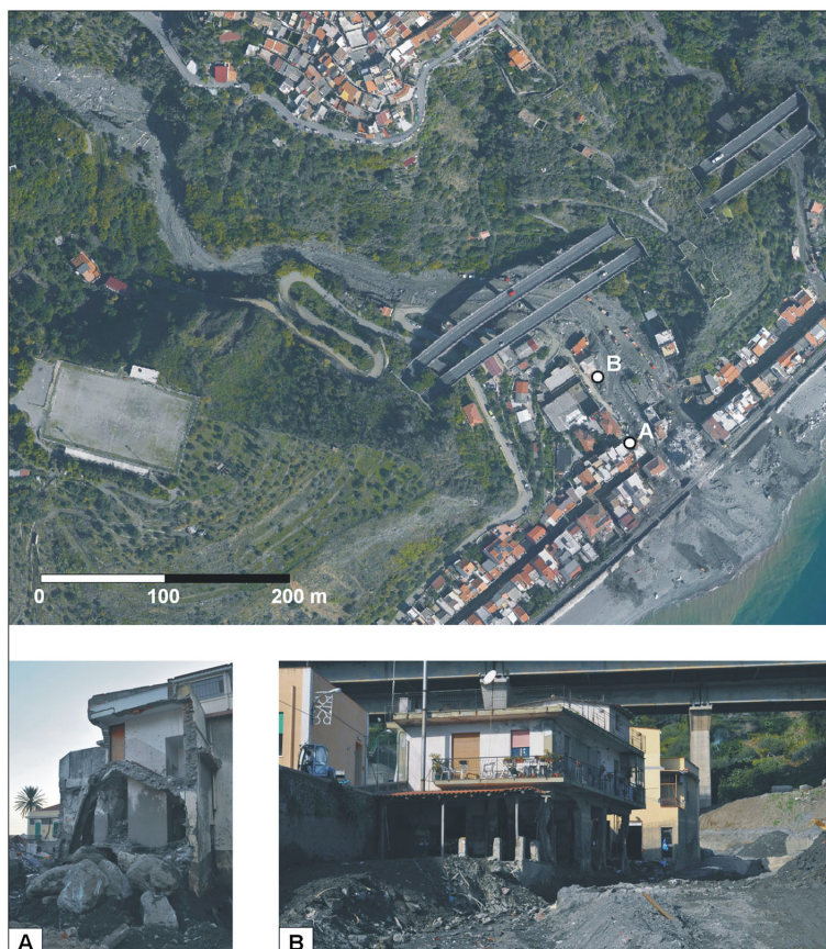
Fig. 4 - Gravi danni registrati in occasione degli eventi dell'1-2 febbraio 2009 lungo la costa a sud di Messina. In alto, immagine aerea della genesi dei flussi di detrito e fango che non sono stati ostacolati dalla presenza della infrastruttura autostradale, di progettazione moderna e con sezioni idrauliche adeguate; in basso, immagini di edifici interessati dagli eventi (Schilirò et al. 2015).
