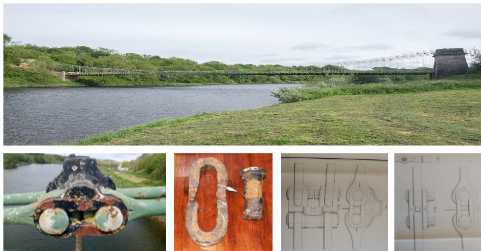
Fig. 2 - Samuel Brown, Union Border Bridge: vista, in alto, e dettagli delle catene, in basso. Le foto sono antecedenti a un importante restauro completato nell'aprile del 2023.
