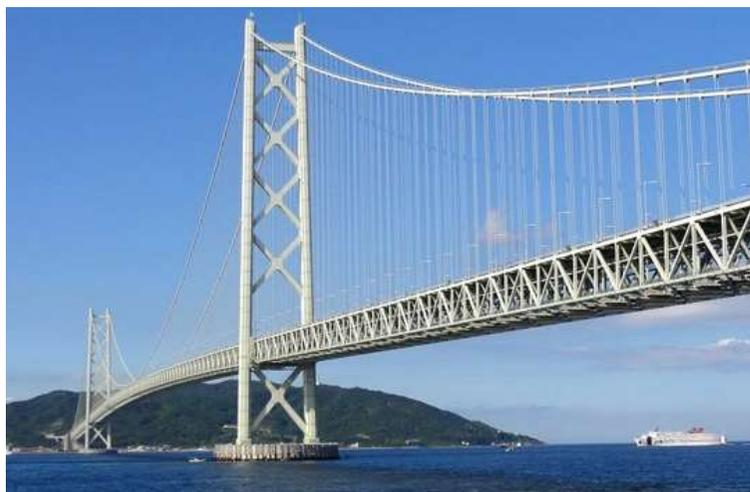
Il grande ponte sull'Akashi era stato inizialmente progettato per essere adibito sia al traffico stradale che a quello ferroviario con passaggio di questo all'interno della sezione reticolare, molto rigida, della travata. **A completamento dell'opera, i treni non sono stati fatti passare sul ponte ma su un tunnel eseguito sotto lo stretto, soluzione impossibile per lo Stretto di Messina.**
