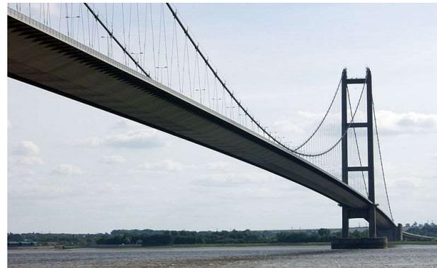
Il ponte sull'Humber (UK), con campata centrale  $L = 1410$  m, adibito a solo traffico veicolare, resta chiuso vari giorni all'anno e determina notevoli vincoli al passaggio di furgoni e camion di largo ingombro. Il ponte non è d'altra parte adibito, come detto, al traffico ferroviario.
